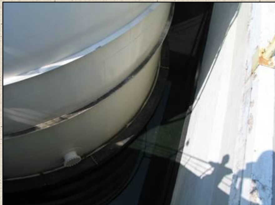
Rys. 2 Zbiornik i wnętrze obmurza zbiornika R1
